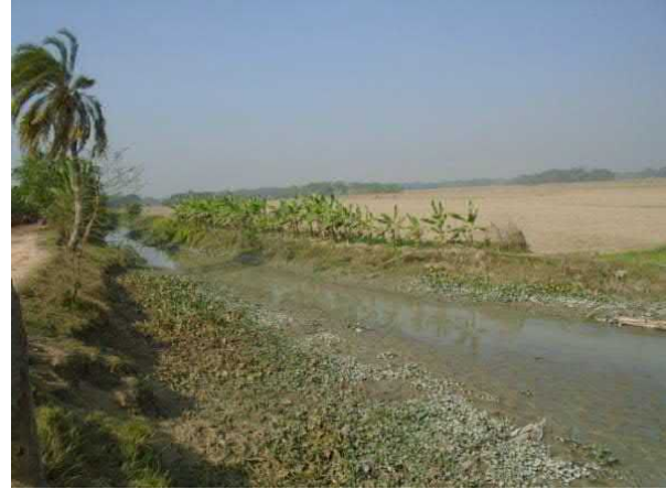
Silted up khal (Kuri kurar khal)
